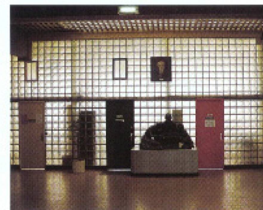
Réception avec cloison de poutre de verre
