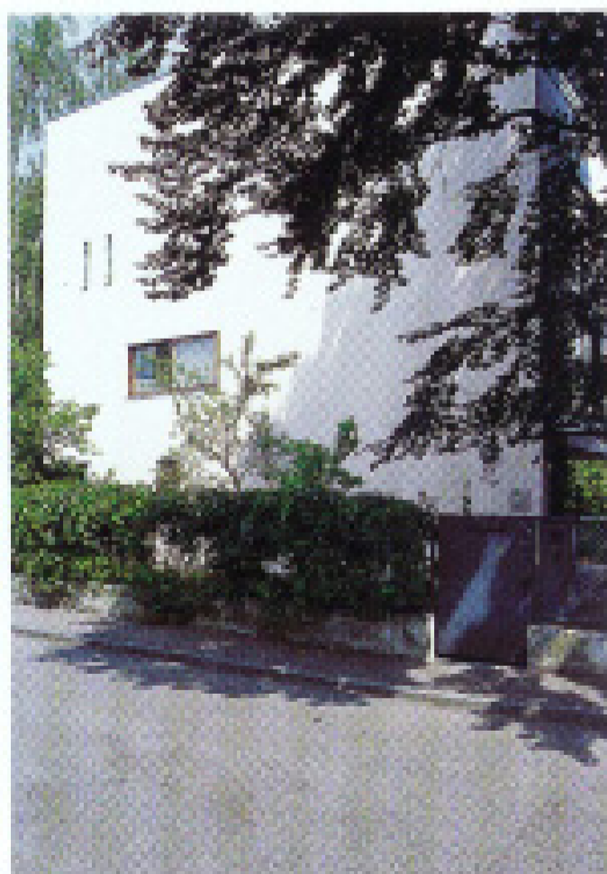
Maison unifamiliale facade nord
