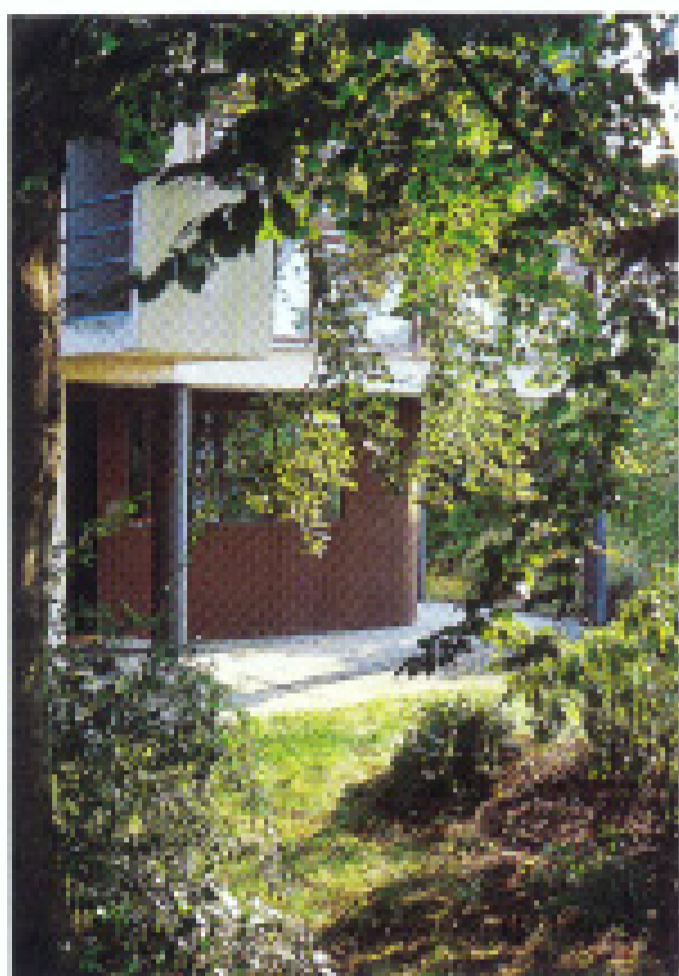
Vue sur jardin et rez-de-chaussée
