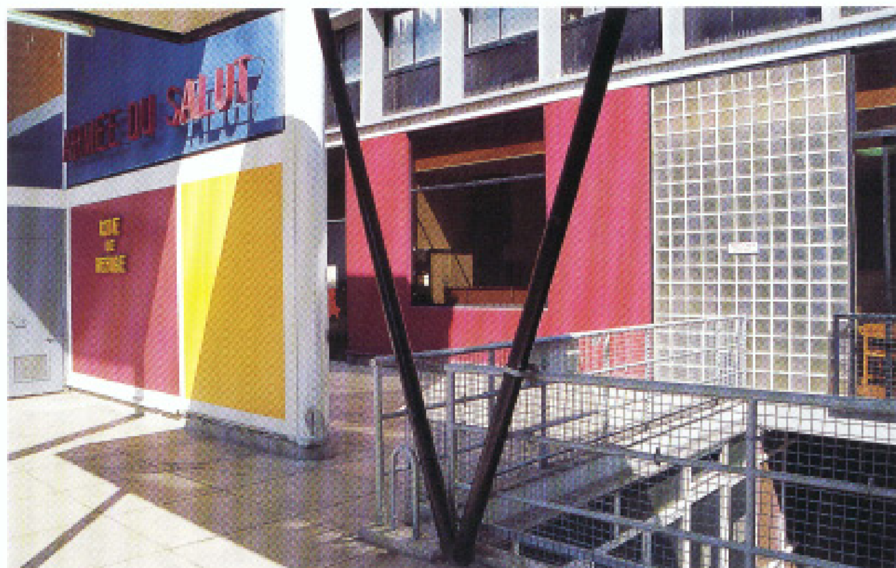
Vue de l'accès par passerelle couverte
