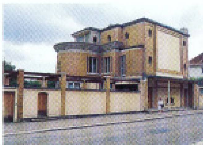
Façade sur rue Angle nord-est
