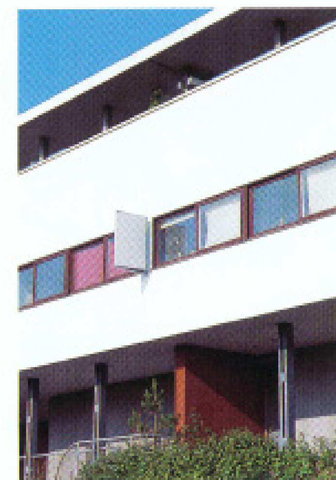
Maison pour deux familles : façade sud et séparatif entre logements
